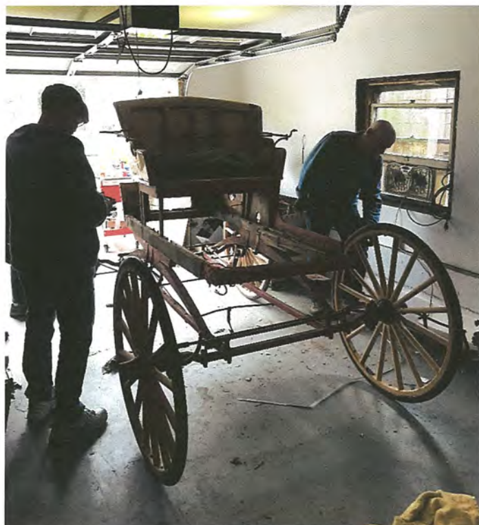
Voila! . . . A rolling chassis
